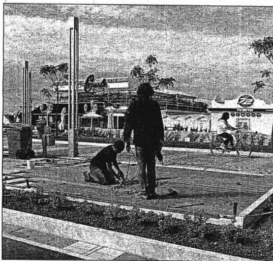
Lavori in corso sul lungomare per il gazebo di Fulvio Binotti
